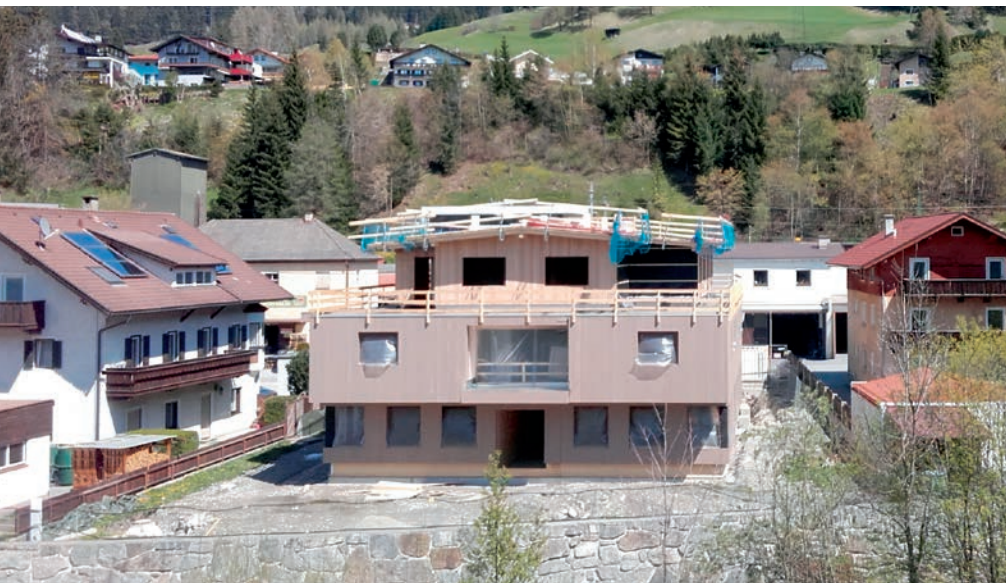
Steinach/Tirol: Der Rohbau des neues Arche-Hauses im Ortszentrum steht bereits
